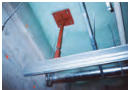
▲天井金具とレールの吊り下げ
